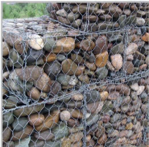
GABION EN CAISSE
